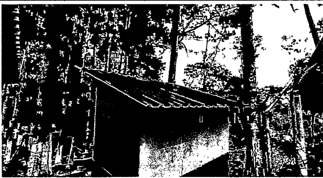
FOTO 15: Se cambió los techos de las letrinas por láminas troqueladas.
